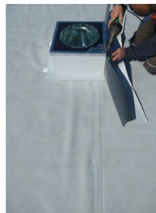
Krok 7 - napojení hydroizolace střechy na střešní základnu
